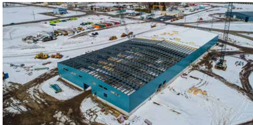
La construction de la nouvelle installation
